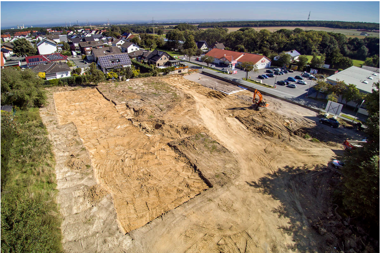
_ Spatenstich Steinhausen, Foto: Michael Kirchner, stadt.fotograf.de
